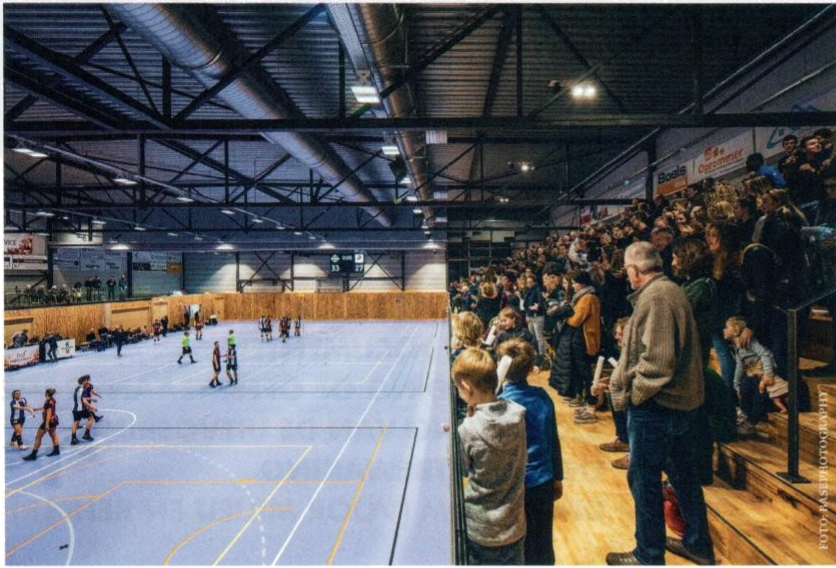
De tribune is geheel geconstrueerd van hout, zodat geen beton hoefde te worden gebruikt.
