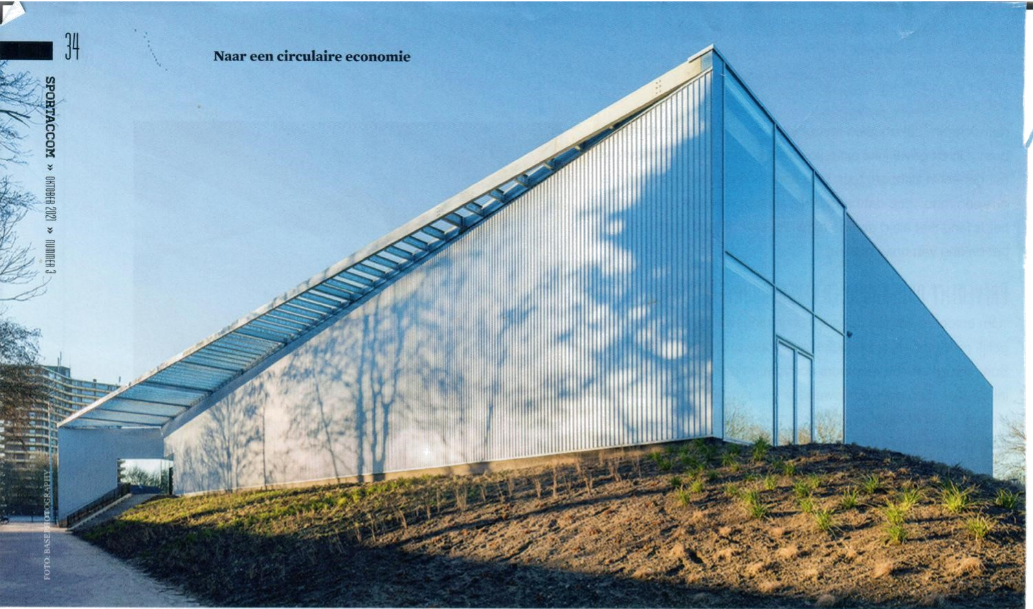
Sporthal Het Binnenveld in Wageningen, ontworpen door Lichtstad Architecten.
